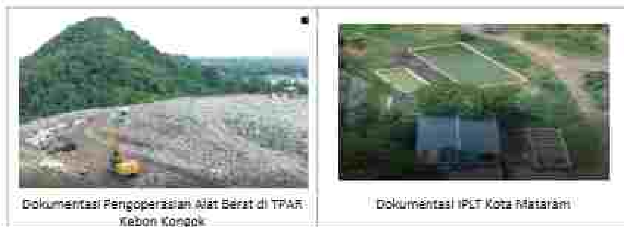
Gambar 2. 2 Dokumentasi Fasilitas di TPA Kebon Kongok
